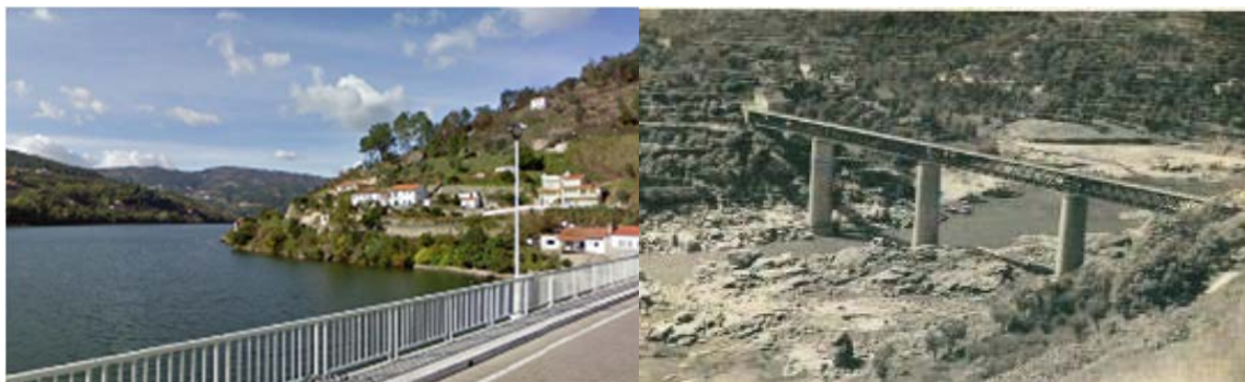
Figura 12. Ponte de Mosteirô: ponto de observação na saída de estudo (à esquerda) e imagem da ponte antiga obtida por estudante na Internet.
